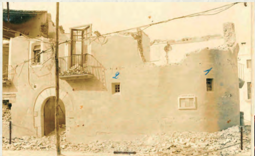
Obres de renovació de la rectoria (Foto: Arxiu parroquial de Cubelles).
